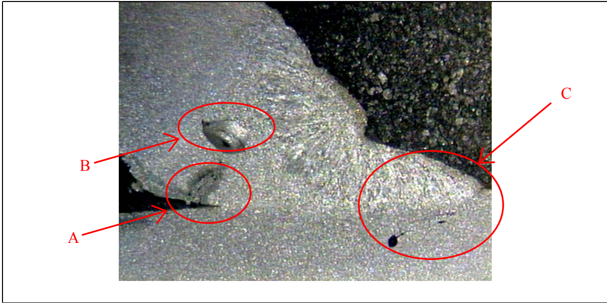
Foto 5- Região 3 (“outro lado”), pode-se ver claramente uma trinca (região A) e um vazio (região B) no cordão de solda (material depositado). Há também uma inclusão acompanhada de uma trinca aparentemente na interface ou na ZTA (região C)
